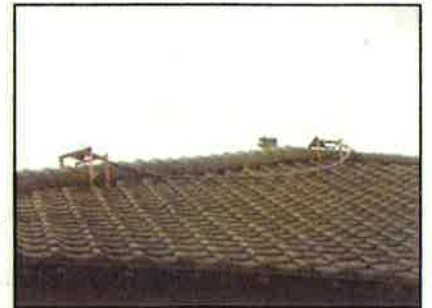
↑牛舎屋根に設置したスプリンクラー
